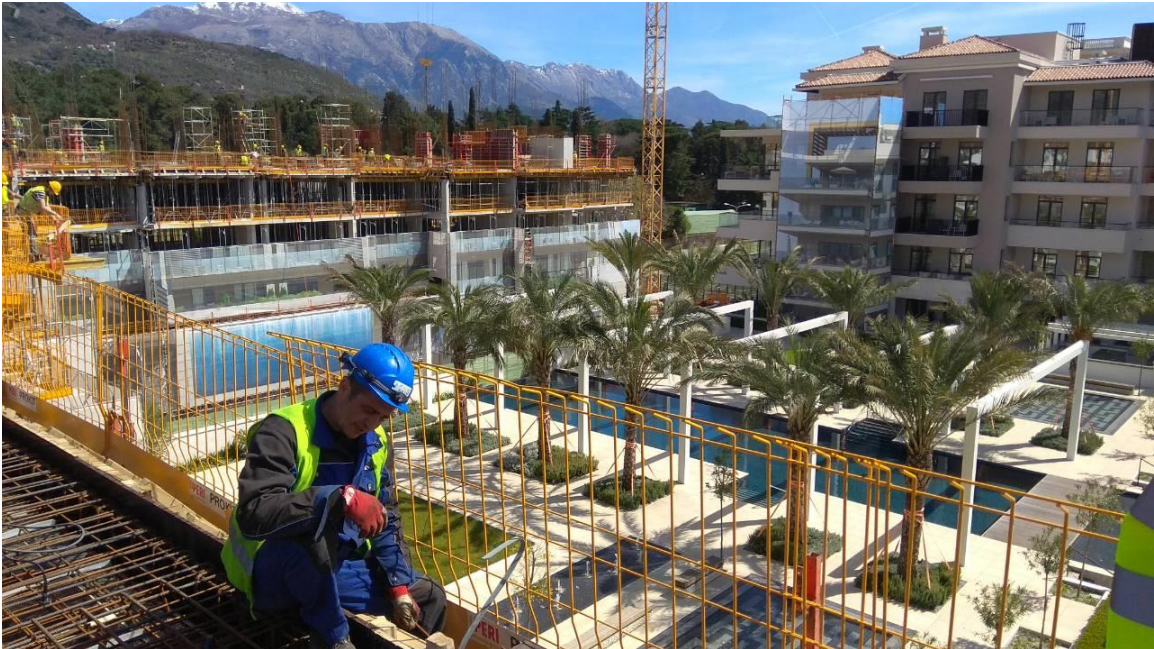
Montaža čelične konstrukcije stepeništa, platformi, pergola i nadstrešnica.
